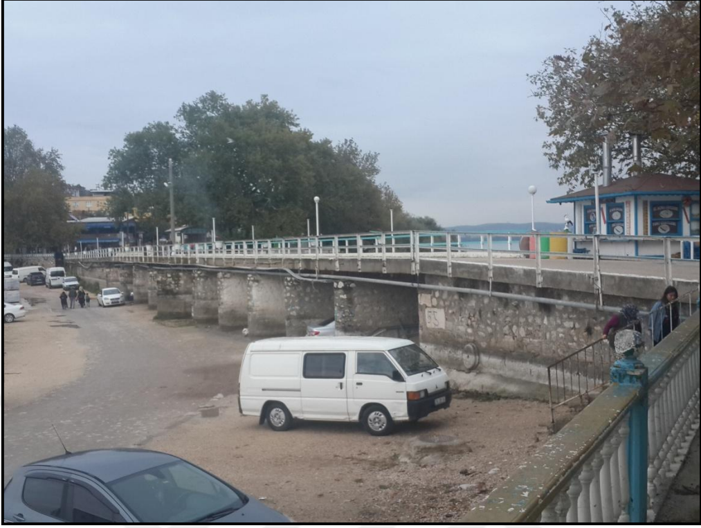
Fotoğraf 2.22: Osmanlı döneminden kalma köprü hala kullanılmaktadır.
