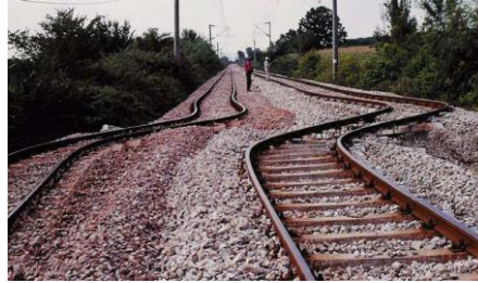
Şekil 4.6. 1999 Marmara depremi sonrasında demiryolu hattında oluşan KYD
