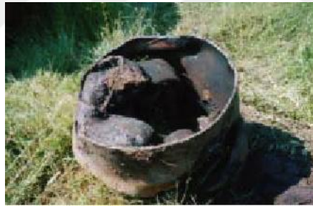
Şekil 4.10. Çelik su borusunun deprem sonucunda burkulmuş hali
