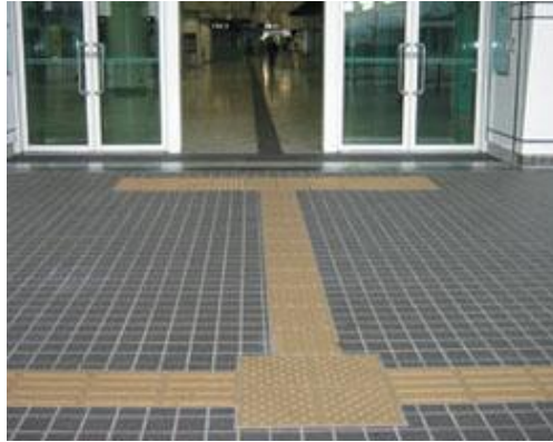
řekil 3.64 Bina giriřinde kılavuz iz, yön deęiřtirme ve uyarı öge kullanımı (Kaplan ve dięer., 2010).
