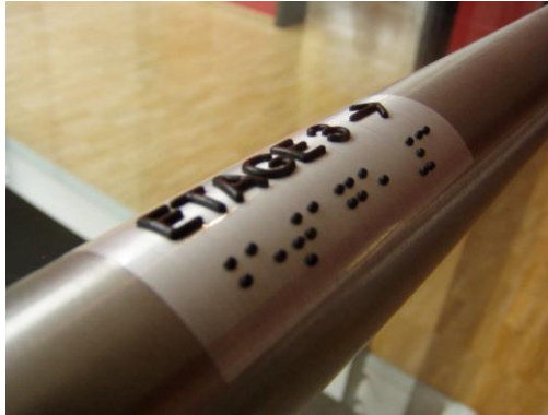
Şekil 3.58 Tutunma barında bulunan kabartma bilgilendirme ve yönlendirme (Archiexpo, b.t.)
