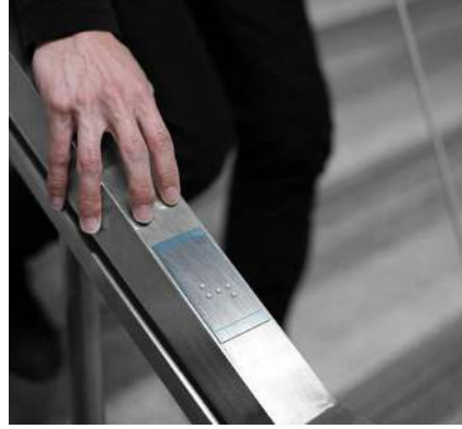
Şekil 3.57 Merdiven küpeştesinde Braille alfabesi ile hissedilebilir bilgilendirme örneği (Yanko, b.t.)
