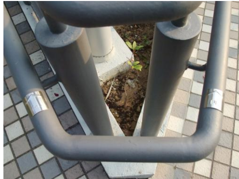
Şekil 3.59 Bahçe korkuluğunda Braille alfabesi ile yönlendirme örneği (Korkuluk, b.t.)
