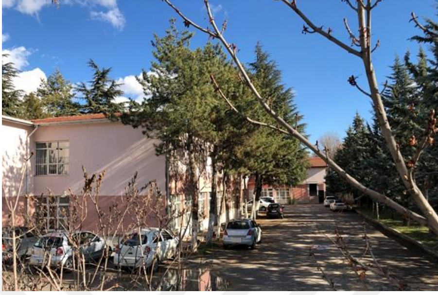
EK-25: Görme Engelliler Ortaokulunun Fotoğrafi
