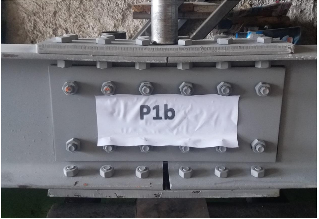
Şekil 4.36. 1.Grup P1a Numunesinin Eğilme Sonrası Durumu
