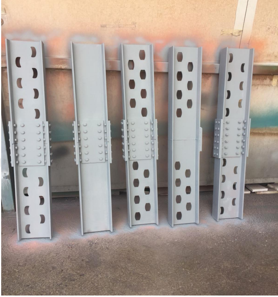
Şekil 4.21. I Profillerin bir kat anti pas ile boyanması
