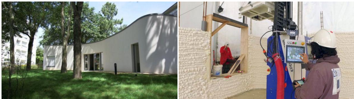
Resim 2-8 / 2-9: 3D yazıcı ile 54 saatte basılan 95 m 2 'lik ev, Yhnova Projesi, 2018, Nantes, Fransa.
