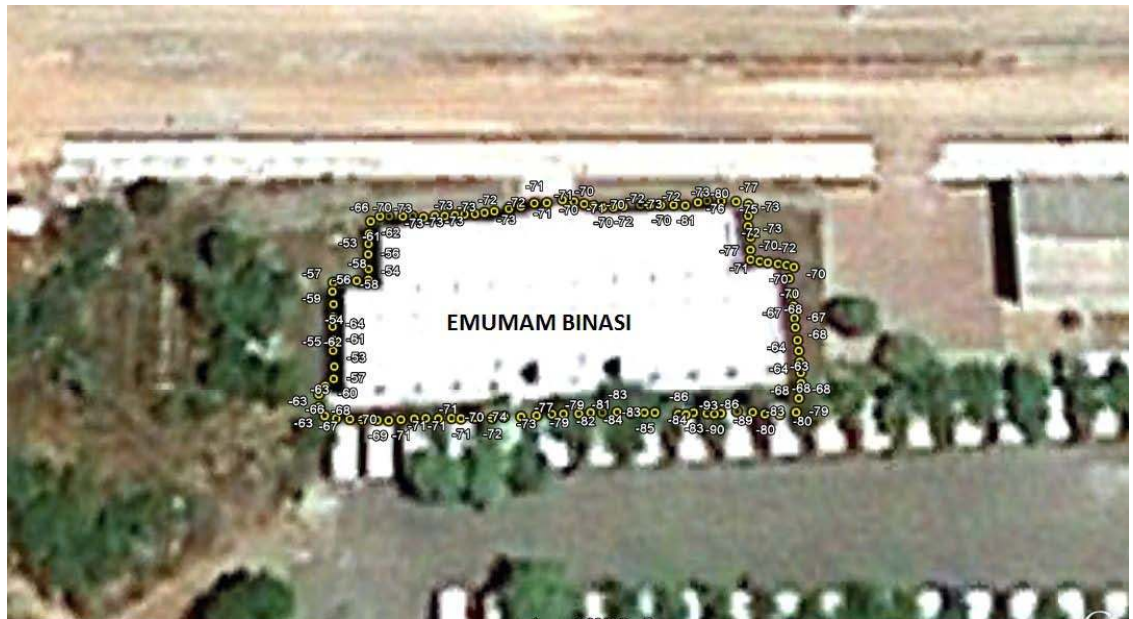
Şekil 3.10. EMUMAM binası ve çevresi boyunca alınan ölçümler
