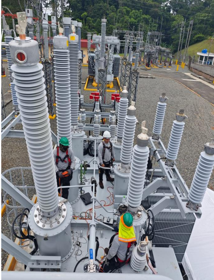
Şekil 2.6. Sahada Montaj Sırasında 400/230/34 kV Güç Transformatörü
