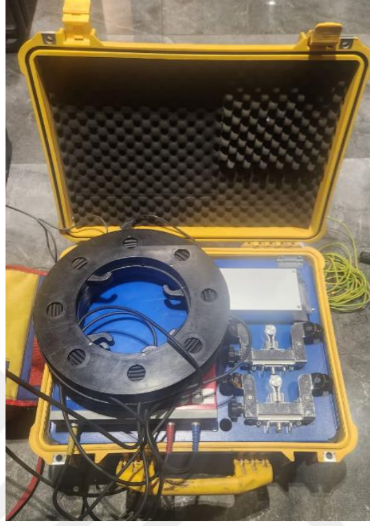
Şekil 4.2. Test Transformatörü Üzerinde Yapılan SFRA Test Düzeneği
