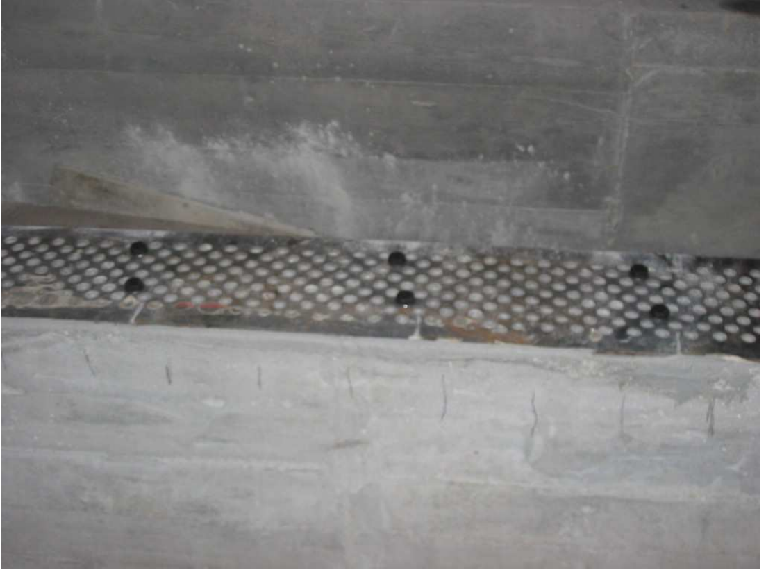
Resim 4.1. Delikli çelik levha ile kiriş güçlendirilmesi
