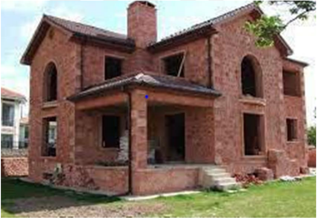
Şekil 1.4. Örnek yığma tuğla yapı ( http://www.google.com )
