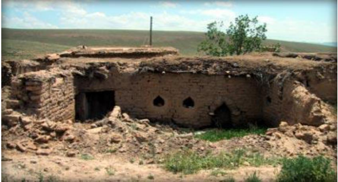
Şekil 1.5. Örnek yığma kerpiç yapı ( http://www.google.com )
