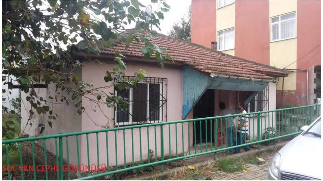
Şekil 6.1. İncelenen yığma yapı
