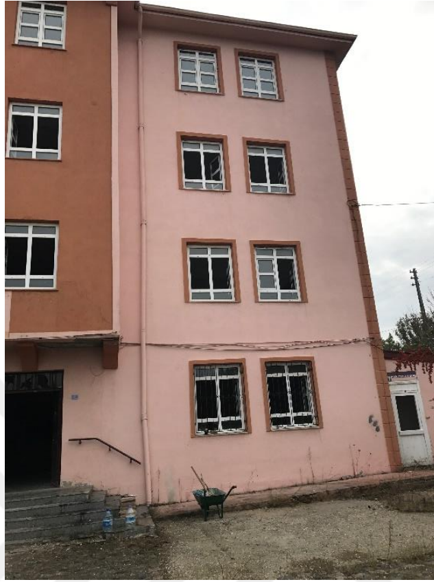
Şekil 4.2. Betonarme yapının görüntüsü
