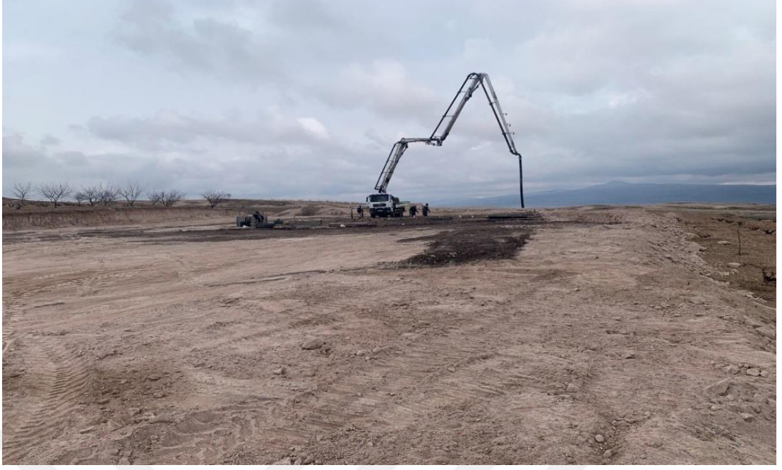
Şekil 7.3. K33d2 paftası Çat kasabası doğusunda belirlenen jeotermal arazisinde alanın düzenlenmesi ve beton atım faaliyeti.
