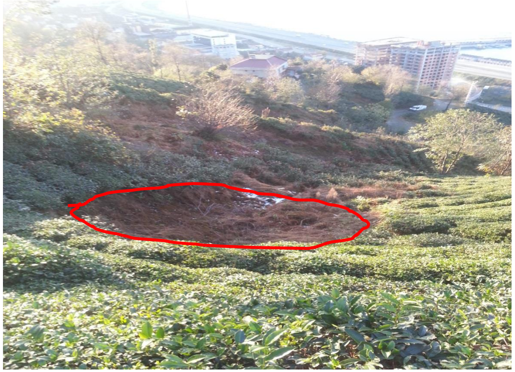
Şekil 3.9. 4 nolu heyelan ve kopan kısımdan bir görünüm
