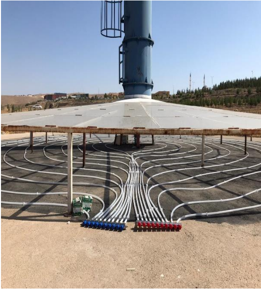
Şekil 3.5. Güneş enerjili sıcak su sistemi döşenmiş kolektör alanı
