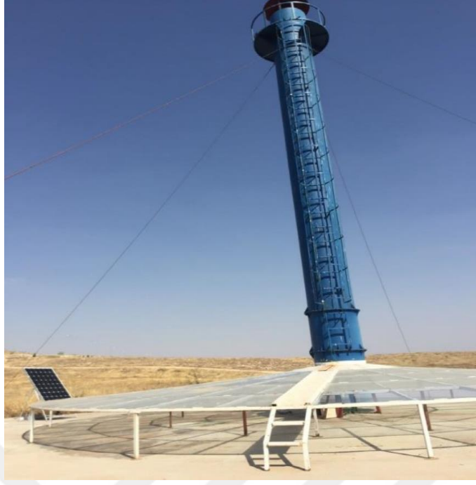
Şekil 3.23. Çalışmanın yapıldığı güneş bacası prototipi (Avcı, 2022)
