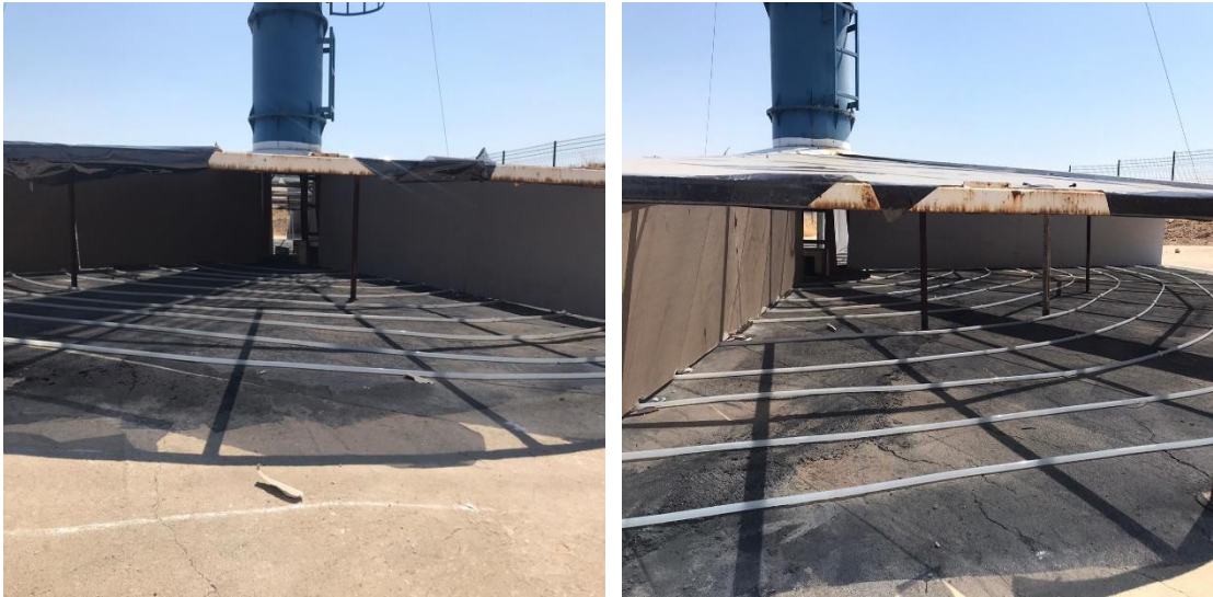
Şekil 3.7. Kolektör alanının bölümlendirilmiş hali
