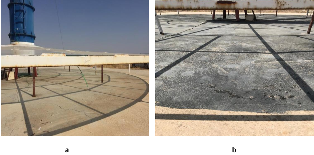
Şekil 3.4. (a) Zeminin boyanmadan önceki hali (b) Zeminin boyalı hali
