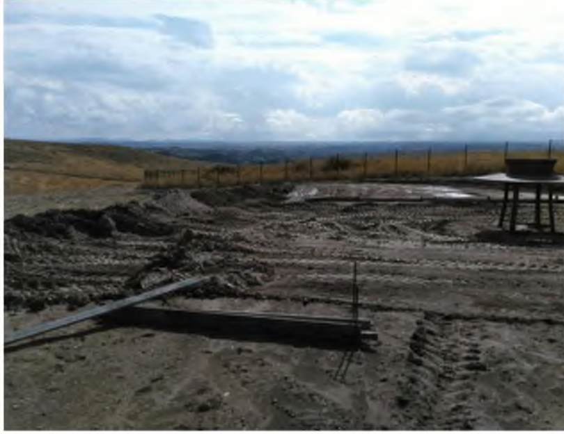
Şekil 3.5. Prototipin kurulacağı zeminin düzenlemesi
