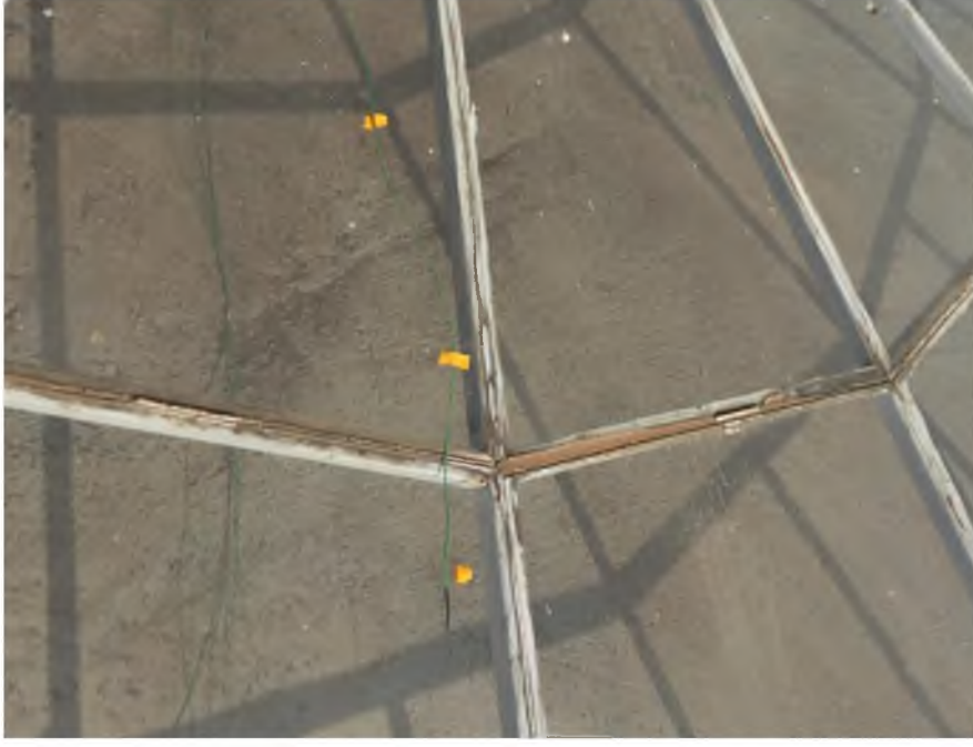
Şekil 3.16. Kolektör üst yüzeyi sıcaklık ölçümü
