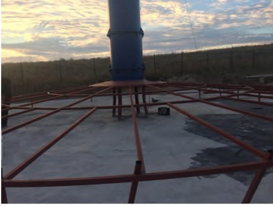
Şekil 3.8. Kolektörün bacaya montajı
