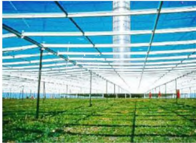
Şekil 2.2. Manzaranes prototipinde kullanılan kolektör (Zhou ve ark. 2010)
