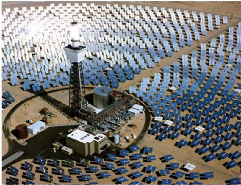
Şekil 1.8. Güneş Kuleleri Teknolojisi (Mojave Çölü)
