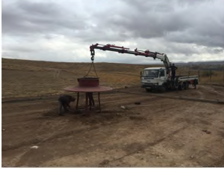
Şekil 3.4. Baca tabanının zemine kurulumu
