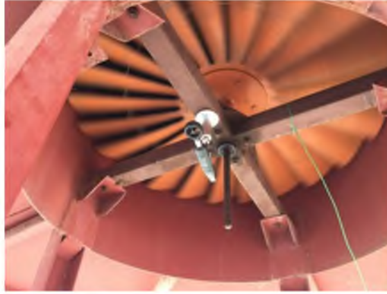
Şekil 3.20. Türbib girişindeki hava hızı ölçümü
