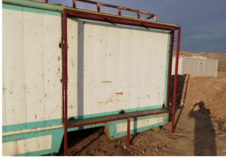
Şekil 3.12. Çelik profilin montajı
