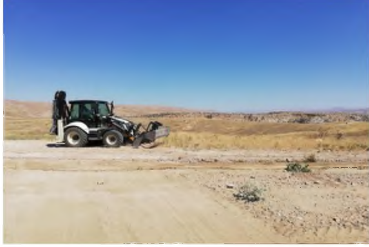
Şekil 3.9. Deney arazisinin düzeltilmesi
