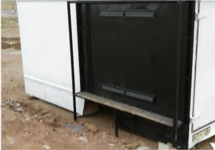
Şekil 3.14. Alt ve üst damperli menfezlerin montajı
