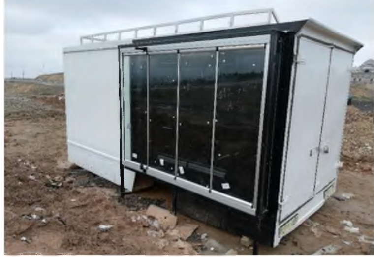
Şekil 3.15. Cam sistemin montajı
