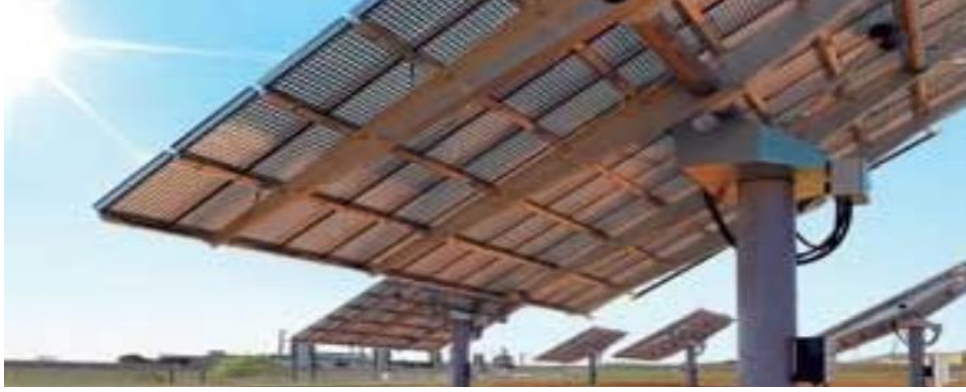
Resim 6. 2. Dikey tek eksenli güneş takip sistemli panel (Yılmaz, 2013)
