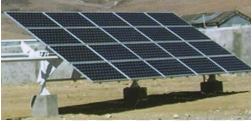
Resim 6. 1. Yatay eksenli güneş takip sistemli panel (Yılmaz, 2013)
