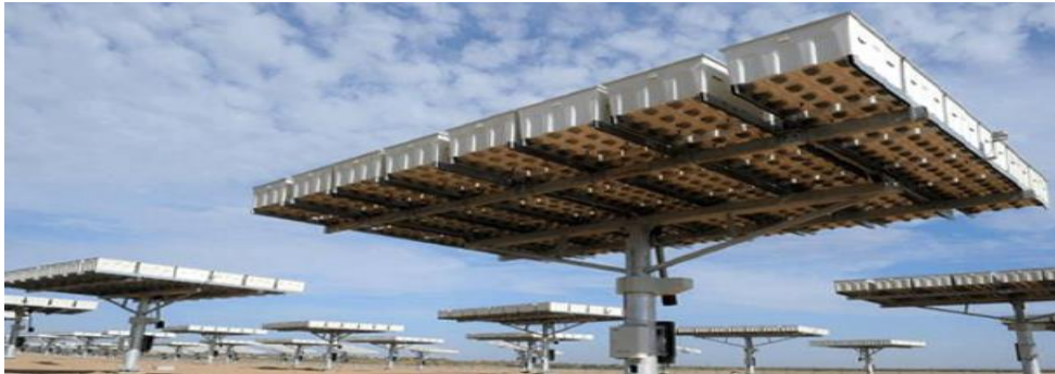
Resim 6. 3. Çift eksenli güneş takip sistemli panel (Korkmaz, 2019)
