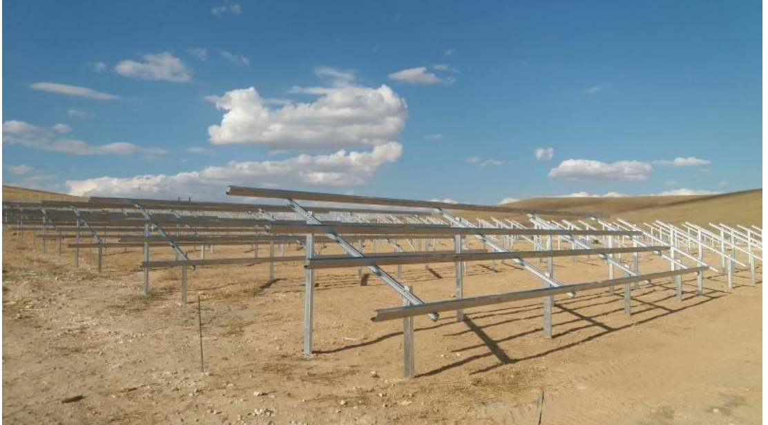
Şekil 2.15. Tek eğimli GES taşıyıcı konstrüksiyon sitemi.
