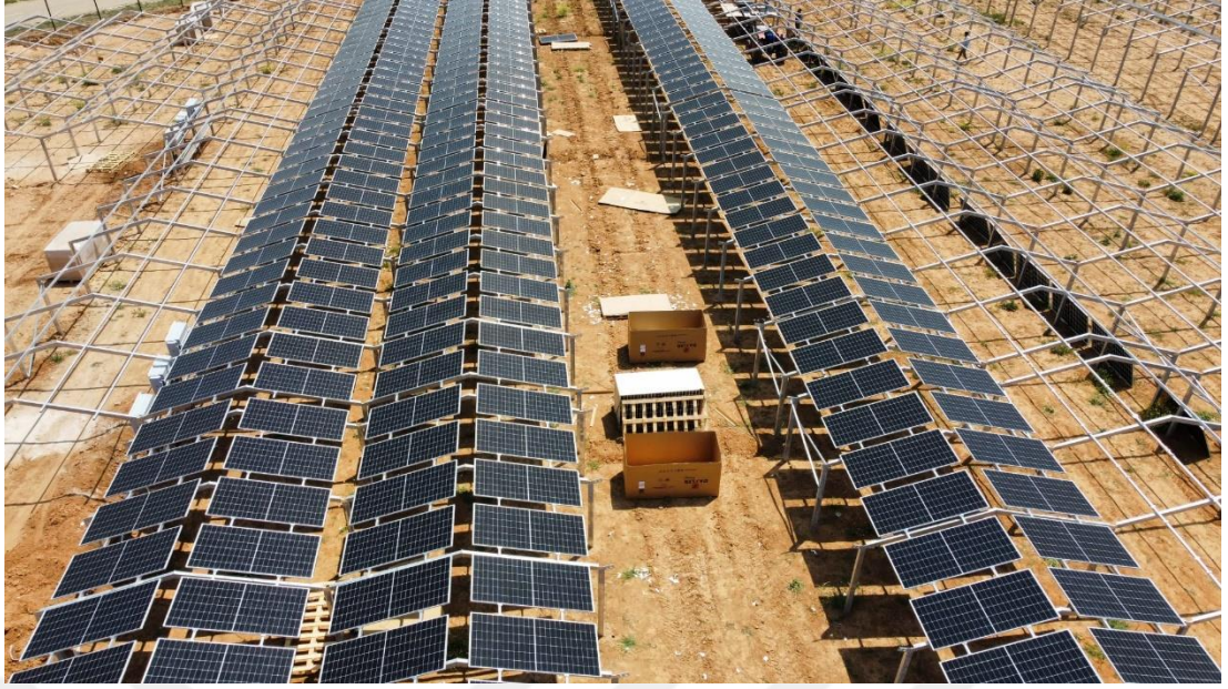
Şekil 2.12. Arazi üzerine kurulumu gerçekleştirilmekte olan çift eğimli GES.
