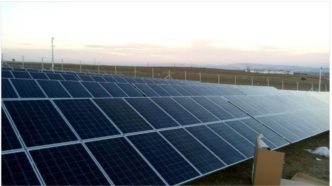
Şekil 2.11. Arazi üzerine kurulumu gerçekleşmekte olan tek eğimli GES.
