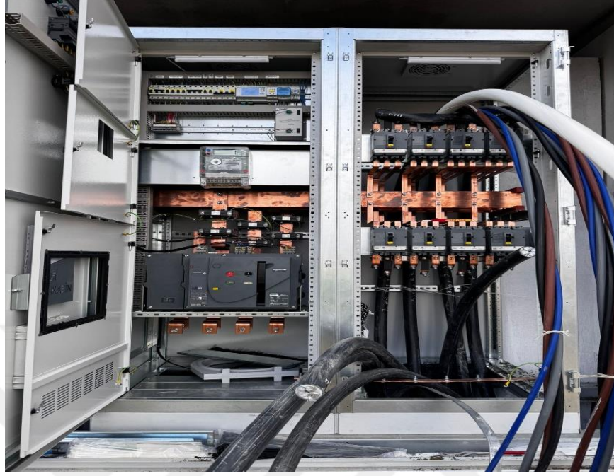
řekil 2.16. Elektrik panosu.
