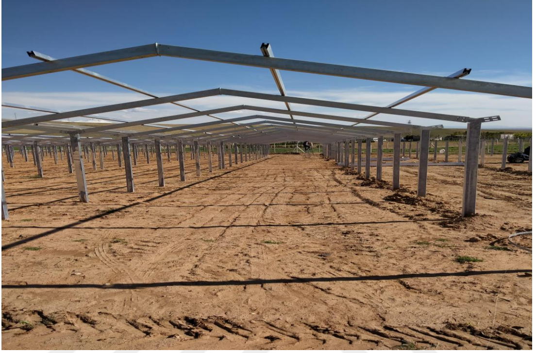
Şekil 2.14. Çift eğimli GES taşıyıcı konstrüksiyon sitemi.
