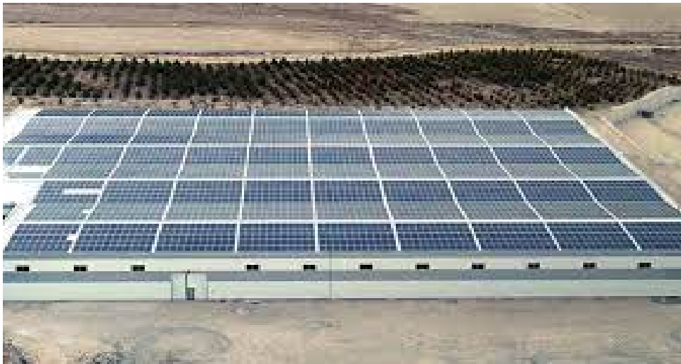
Şekil 4.8. Oylum güneş enerji santrali uygulama görseli
