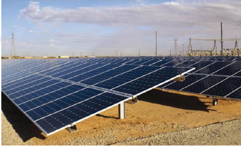
Şekil 2.2. Elektrik enerjisi santralinde fotovoltaik panellerin yerleşimi [34].
