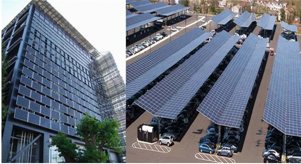
Şekil 3.11. Güneş Paneli Sistemlerin Kuruldukları Yerlere Örnekler
