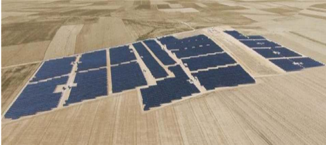
Şekil 3.6. Kızören Güneş Enerjisi Santrali
