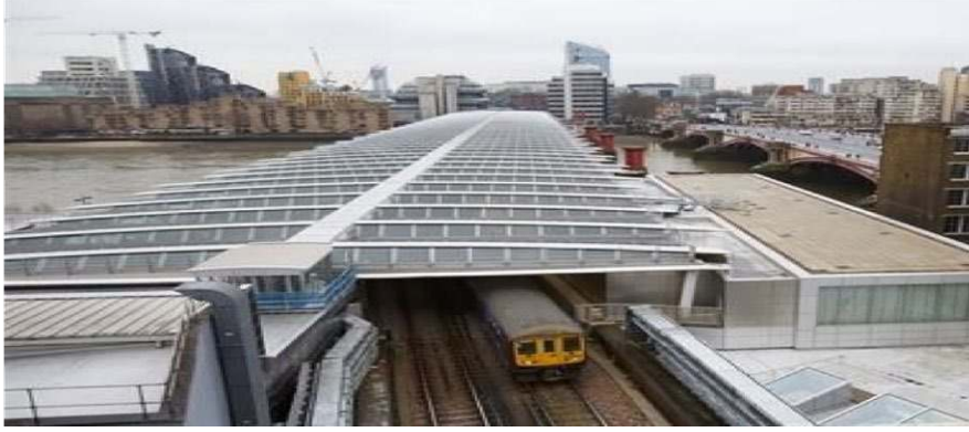
Şekil 3.9. Londra’da Elektrik Üreten Güneş Panellerine Sahip Blackfriars Köprüsü
