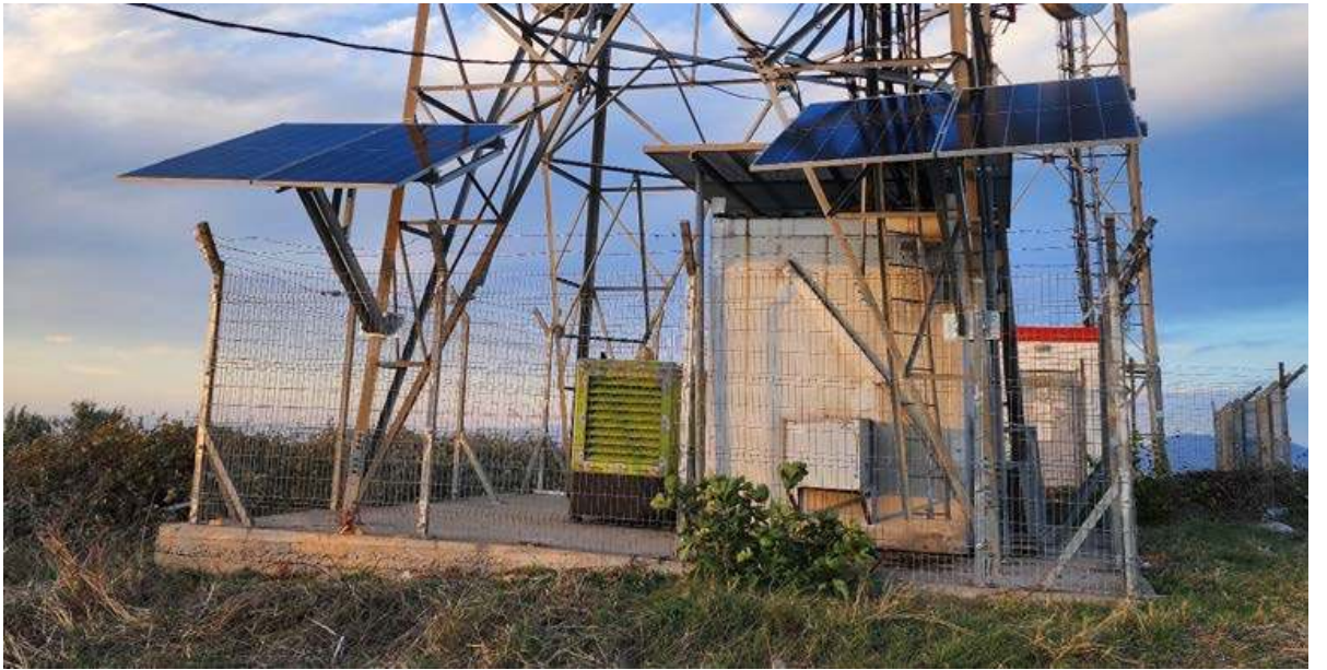
Şekil 3.1. Baz Kulesine Montajlanmış GES Çelik Yapısının Gösterimi
