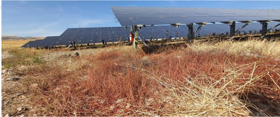
Resim 2.9. Güneş enerji santralinin etrafındaki kurumuş bitki örtüsü.
