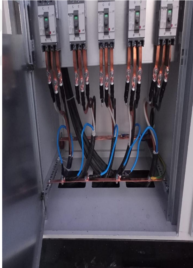
Şekil 5.11. İnverter 'den GES panosuna gelen AC kablonun TMS montajı
