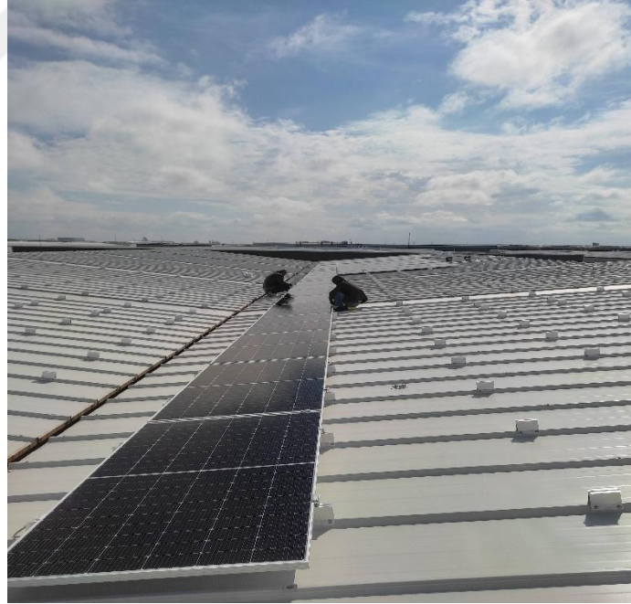
Şekil 5.3. Güneş paneli montajı
