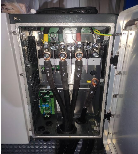
Şekil 5.10. İnverter AC kablo montajı
