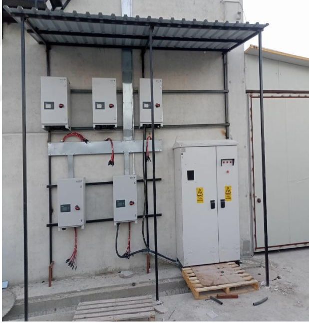
Şekil 5.7. İnverter montajı 2
