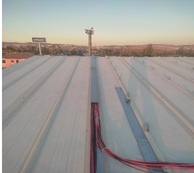
Şekil 5.4. DC kablo montajı
