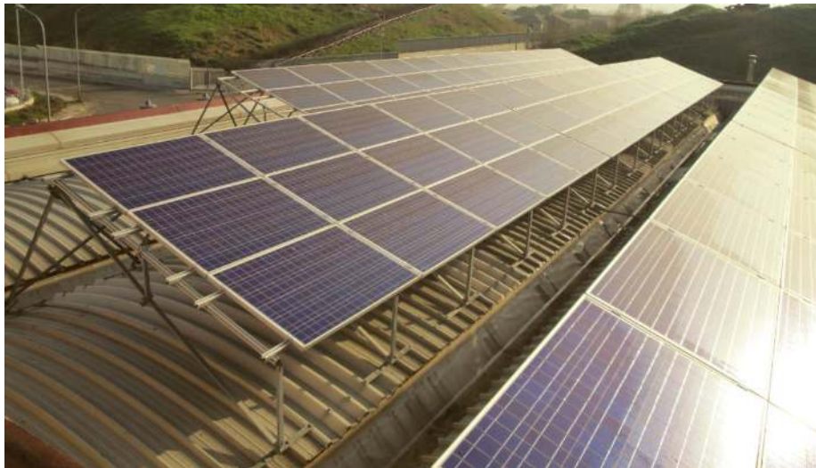
Şekil 3.14 Oval çatıya uyarlanmış aynı eğimde, üst üste ve tek sehpa FV sistem
