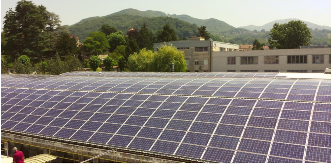
Şekil 3.13 Oval çatıya uyarlanmış farklı eğimlerde panel yerleşimi
