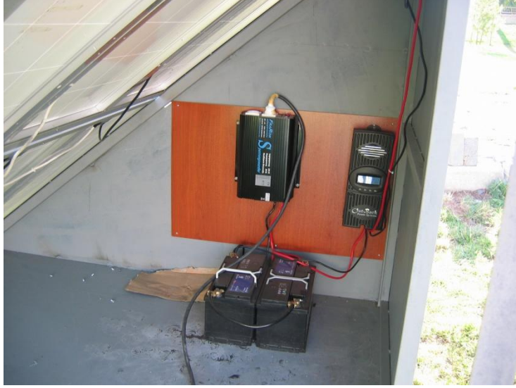
Şekil 4.8. Uygulama Sitemindeki bataryalar, evirici ve MPPT
