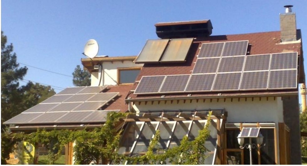
Şekil 4.2. Güneş gözelerinin çatıya monte şekli
