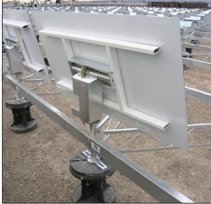
Şekil 1.10 Küçük heliostatlar için düşük maliyetli destek yapısı (Kaynak: eSolar) (Bonanos vd., 2014)
