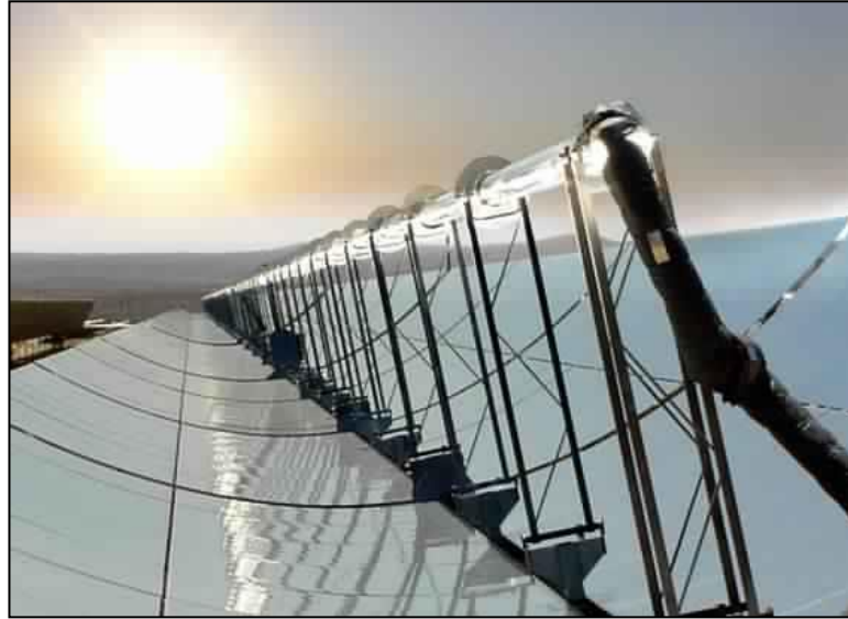
Şekil 4.1 Doğrusal yoğunlaştırıcılar ile elektrik üretimi
