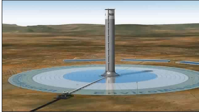
Şekil 4.4 Güneş bacası ile elektrik üretimi
