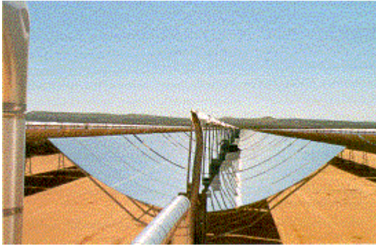
Resim 2.3. Parabolik oluk kolektörleri
