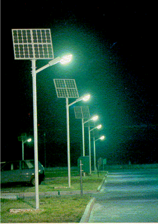
Resim 2.9. Güneş pilleri ile sokak aydınlatması
