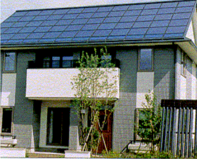
Resim 2.8. çatısı güneş pili kaplı ev
