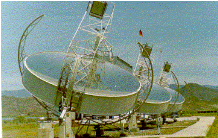
Resim 2.5. Parabolik çanak güneş ısı elektrik santrali (İspanya)
