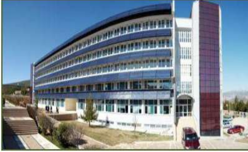
Şekil 4.10. Muğla Üniversitesi Rektörlük binasına entegre fotovoltaik sistem [36]
