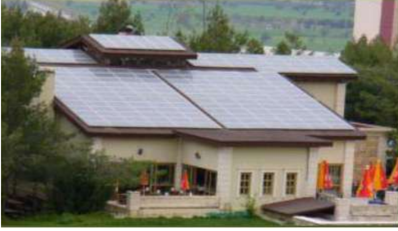
Şekil 4.8. Muğla Üniversitesi kafeterya çatısında fotovoltaiik sistem [36]
