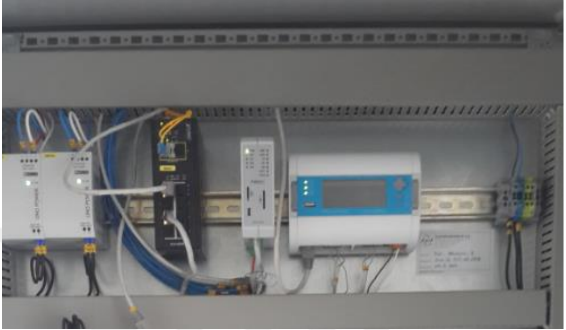
Şekil 3.19. GES İnverter Kontrolü İçin Montajı Yapılan Datalogger Test Düzeneği
