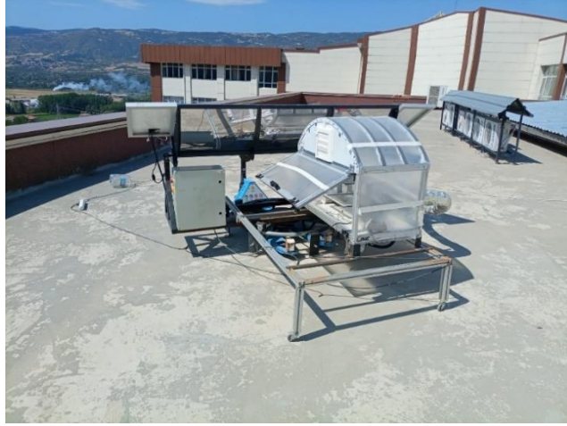
Şekil 3.33. Kurutma sitemi elektrik bağlantı hattının çekilmesi işlemi
