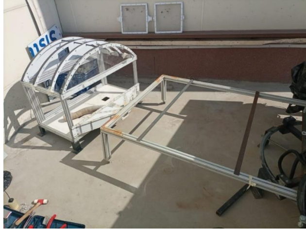
Şekil 3.27. Sera kabinin ana gövde montajı
