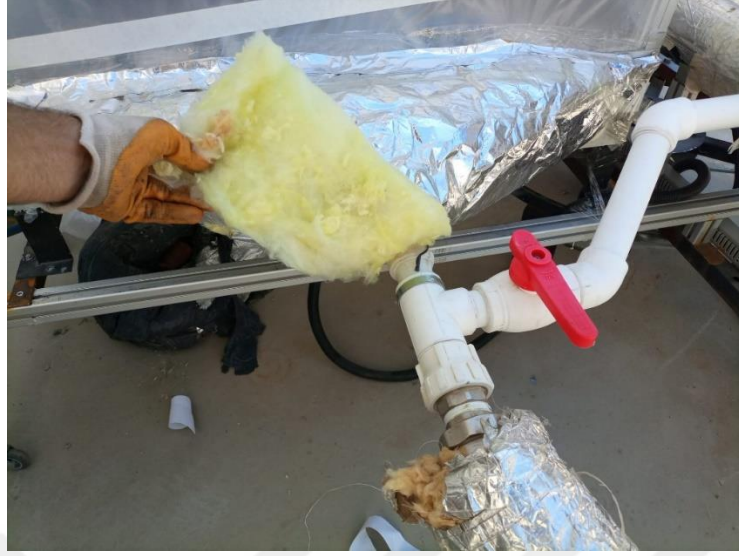
Şekil 3.31. Kabin hava kanallarının ısıcam malzemesi ile kaplama işlemi
