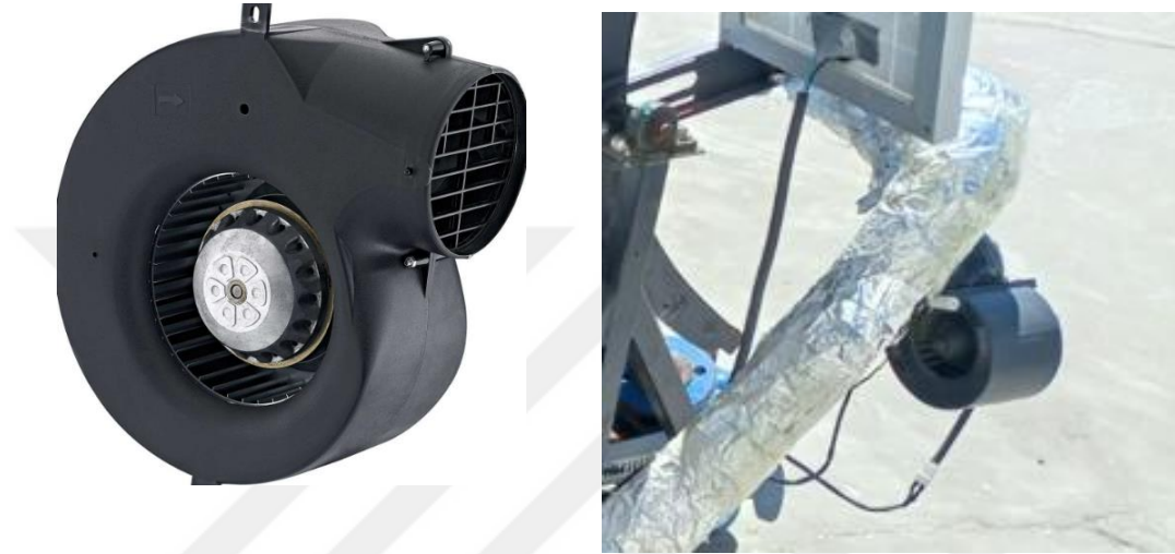
Şekil 3.35. Salyangoz fan motoru ve kurutma sisteminde gösterimi
