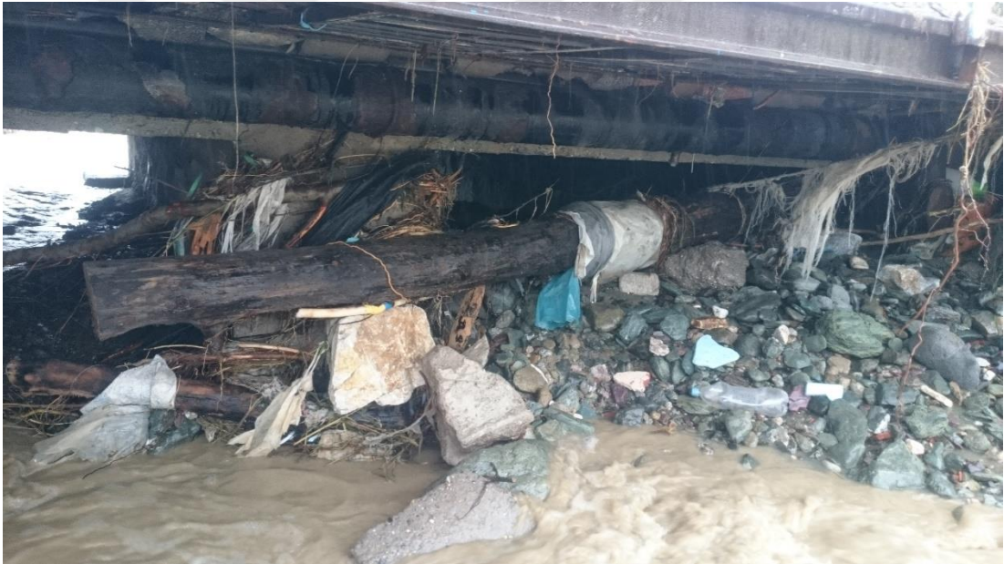
Şekil 5.12. Sapanca Sarp Deresinde yetersiz köprü kesiti ve orta ayak sebebiyle biriken rusubat
