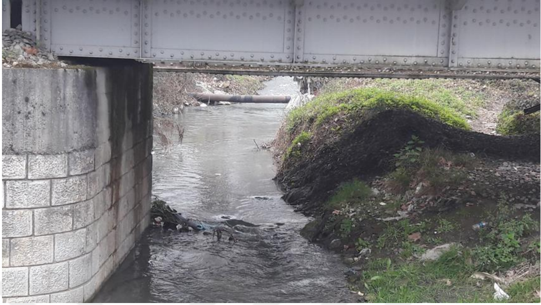
Şekil 2.4. Sakarya Sapanca İstanbulderesi yatak içinden geçen içme suyu borusu ve kesiti daraltan rusubat
