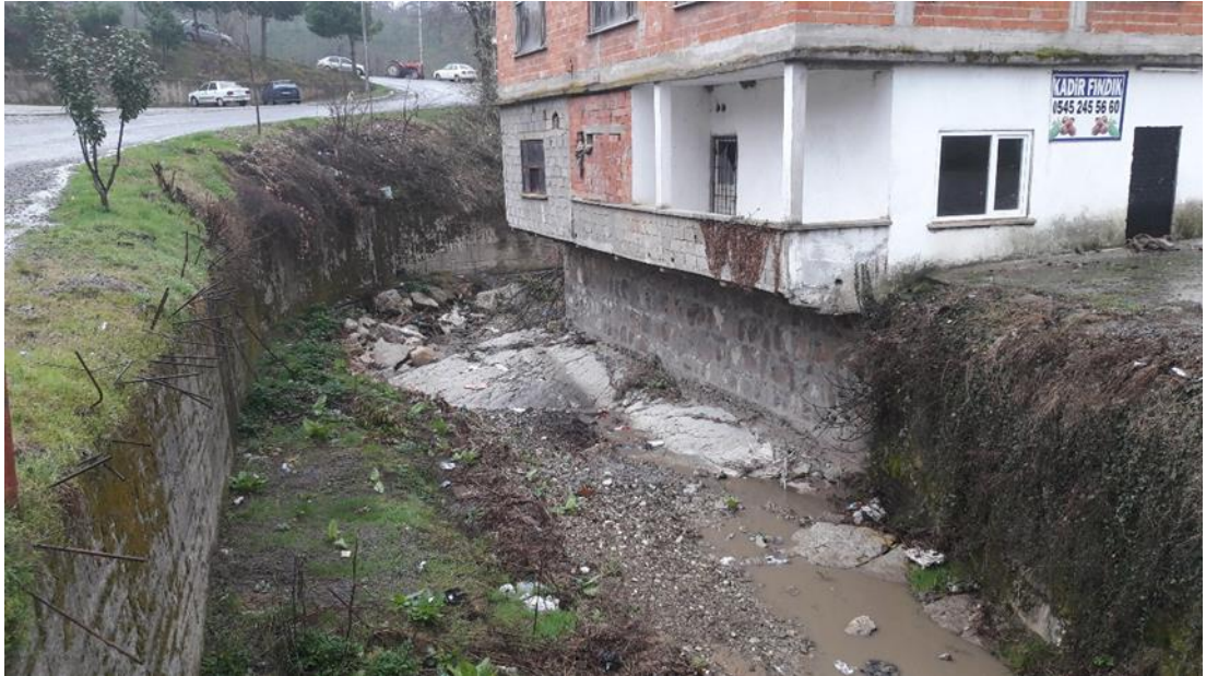
Şekil 2.2. Sakarya Karasu Kızılıcık deresi yatak içine inşaa edilen ve kesiti daraltan yapı
