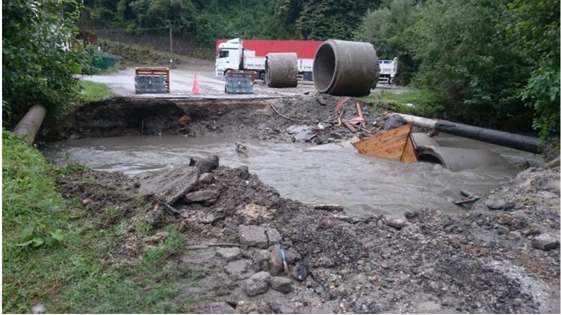
Şekil 5.6. Sapanca Mahmudiye Deresi akışı engelleyen büzlerin kaldırılması
