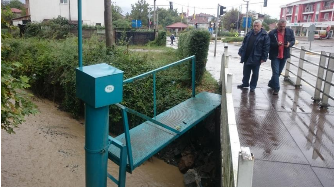
Şekil 5.10. Sapanca Keçi Deresinde hasar gören DSİ AGİ tesisi
