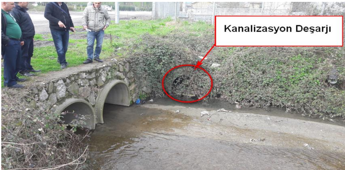
Şekil 2.9. Sakarya Sapanca Keçi Deresinde, dereye kanalizasyon deşarjı
