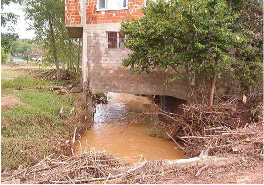
Şekil 2.1. Sakarya, Kocaali, Demiraçma Deresinde daraltılan kesit (İslah öncesi)
