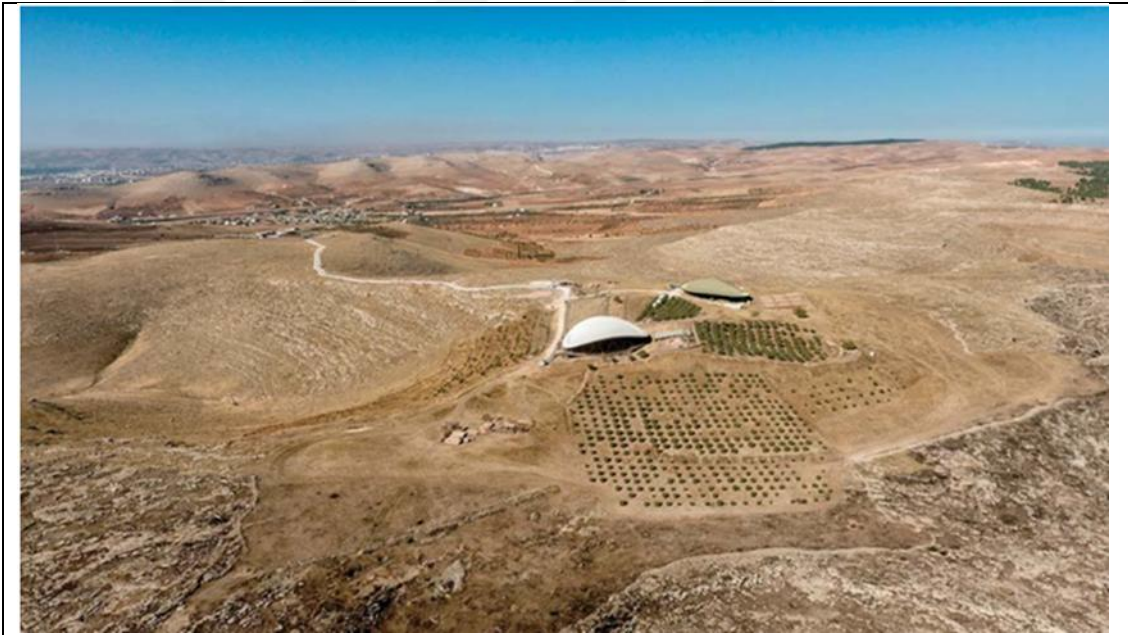
2017 yılında inşa edilen ve kuzeybatı (sol üst) ile güneydoğu çöküntülerini (sağ alt) örten iki kalıcı koruma örtüsünü göstermektedir (Karul, ve diğerleri, 2025, s. 70; Clare, 2024, s. 23).
