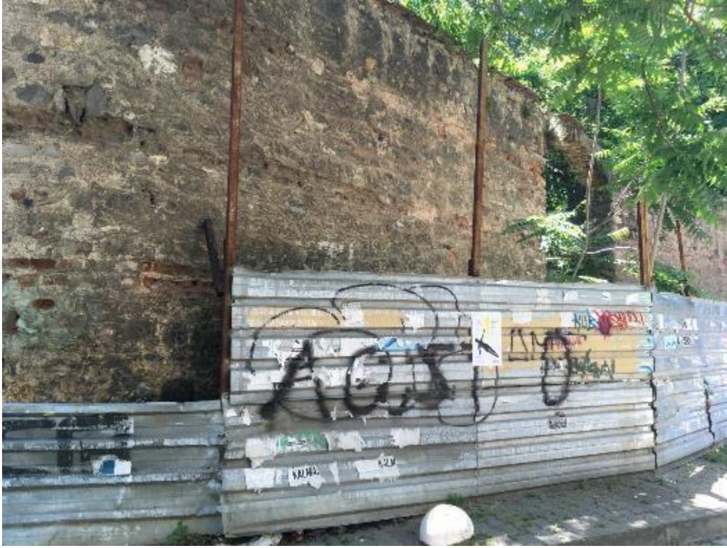
Resim 73: Lorando Köşkü'nün Bahçe Duvarı, Şair Nefi Sokak, Moda, 2019
