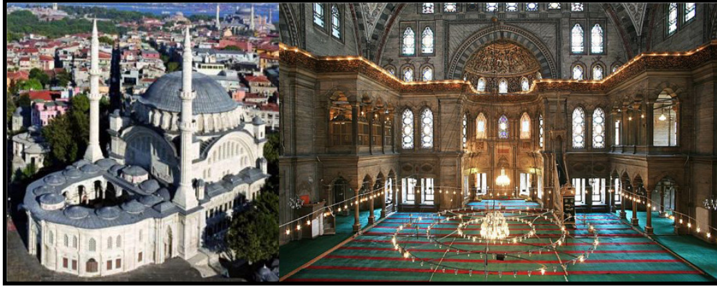
Şekil 3.50 Nuru Osmaniye Camii dış ve iç görünüş ( http://wowturkey.com )
