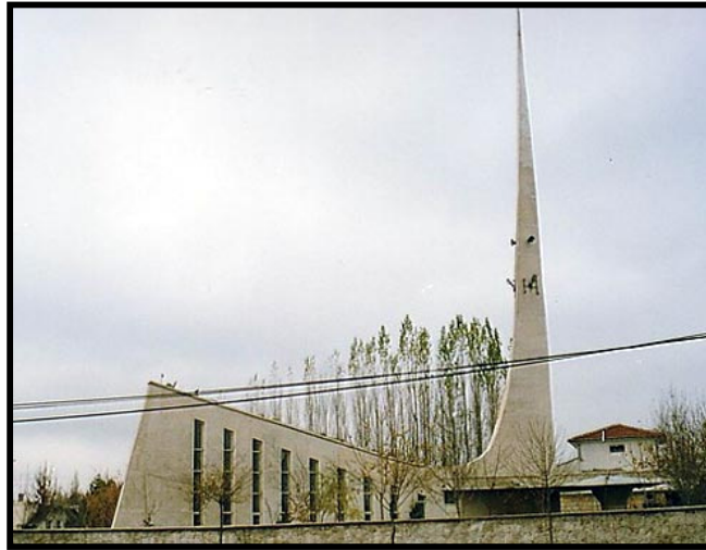
Şekil 3.60 Derinkuyu Park Camii dış görünüş
