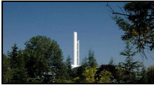
Şekil 4.24 Mogan Camii minaresi görünüşü (www.arkitera.com)
