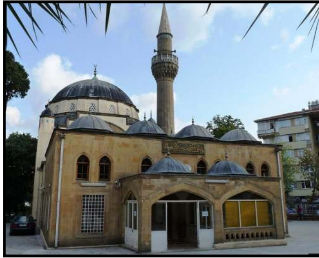
Şekil 3.55 Bostancı Kuloğlu Camii dış görünüşü
