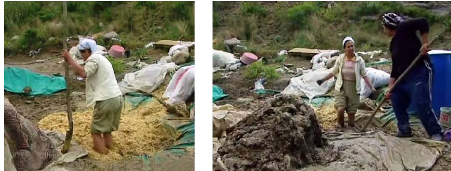
Fotoğraf 141: Saman ilavesi ve çamurun hazırlanması
