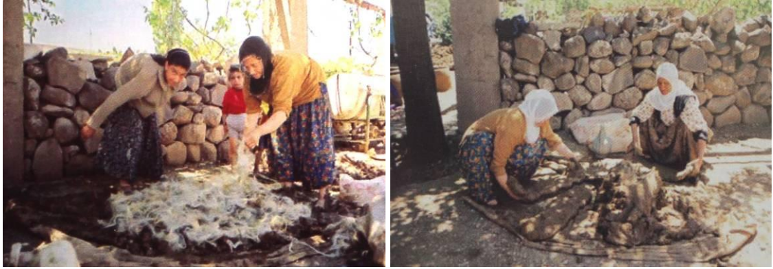
Fotoğraf 105: Hazırlanan çamura keçi kılı ilavesi ve çamurun yoğrulması (Daşdağ, 2013: 276)
