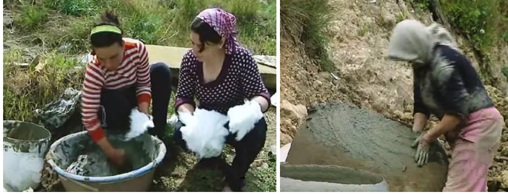
Fotoğraf 144: Pamuk katkılı bulamacın hazırlanması, sıvama işlemi (Öksüz, 2010)
