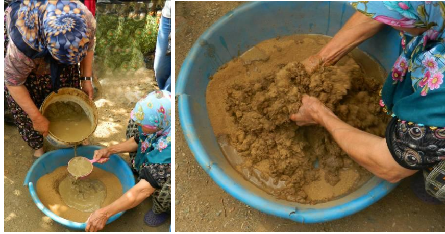
Fotoğraf 146: İki toprağın karıştırılması ve çamurun hazırlanışı
