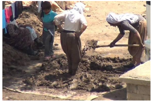
Fotoğraf 88: Toprağın çıkarılması ve çamur hazırlanışı
