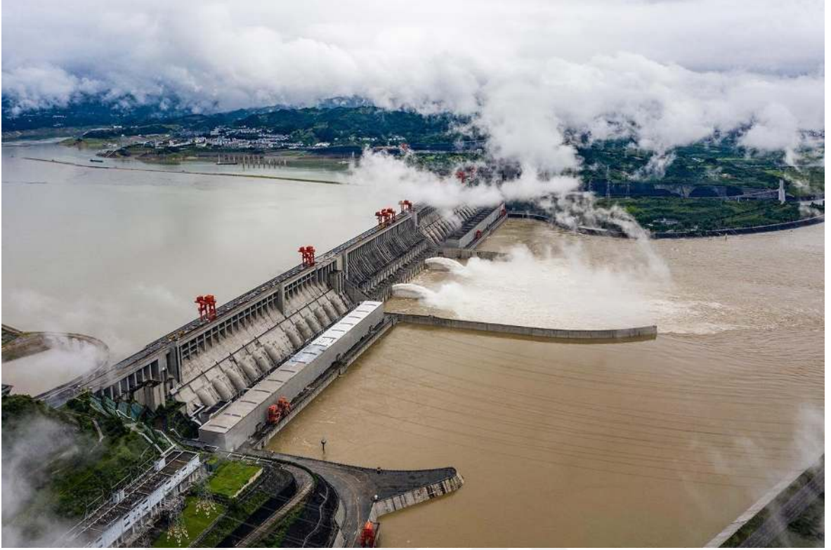
Şekil 2. Çin'de Three Gorges Barajı
