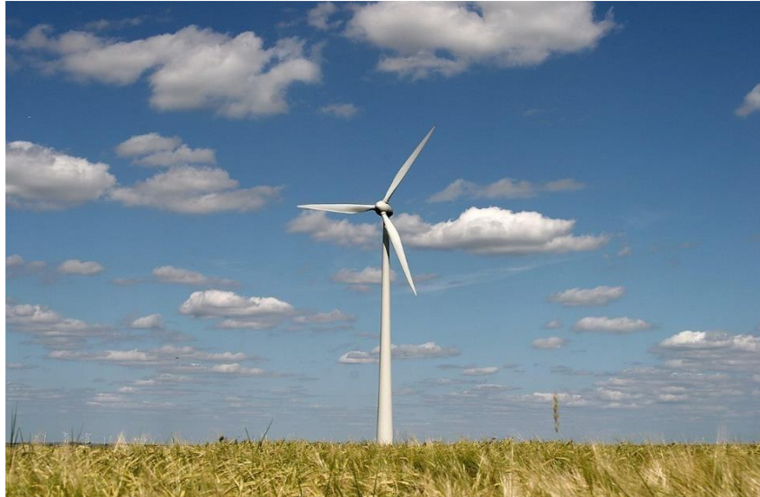
Şekil 8. Lüksemburg'da Rüzgar Türbini
