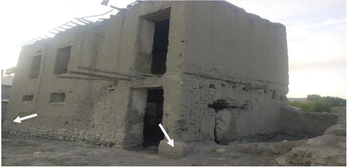
Fotoğraf 2. 3. Çavuştepe Mahallesiinde Üzerinde Haç İşaretleri Bulunan Eski Bir Yapı
