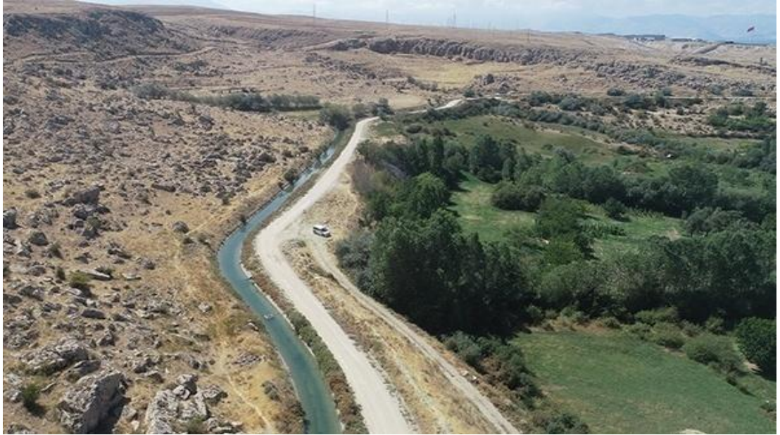
Fotoğraf 3.11. Halen kullanılan Şamran (Menua) Kanalı'ndan görünüm
