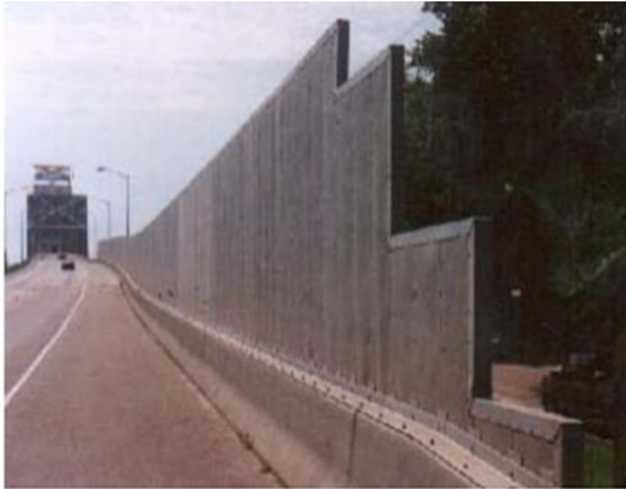
Şekil 3.2. Otoyol kenarında absorban malzeme kullanılarak oluşturulmuş gürültü bariyeri (Karadayı, 2001)
