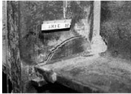
Şekil 1.4. Kolon Başlığı Kırılması (FEMA, 351)
