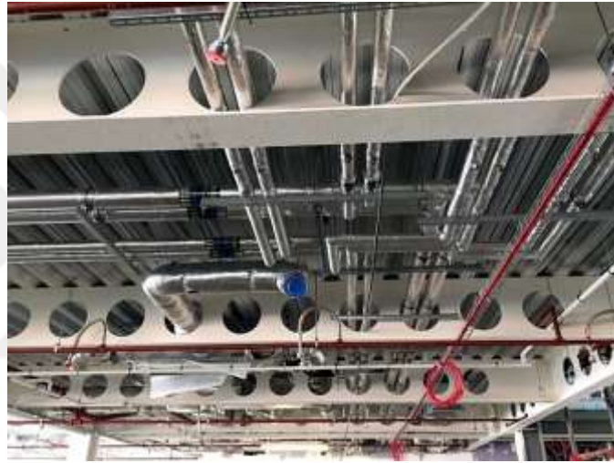
Şekil 2.23. Çelik Kirişlerinde Hizmetler için Oluşturulan Açıklıklar
