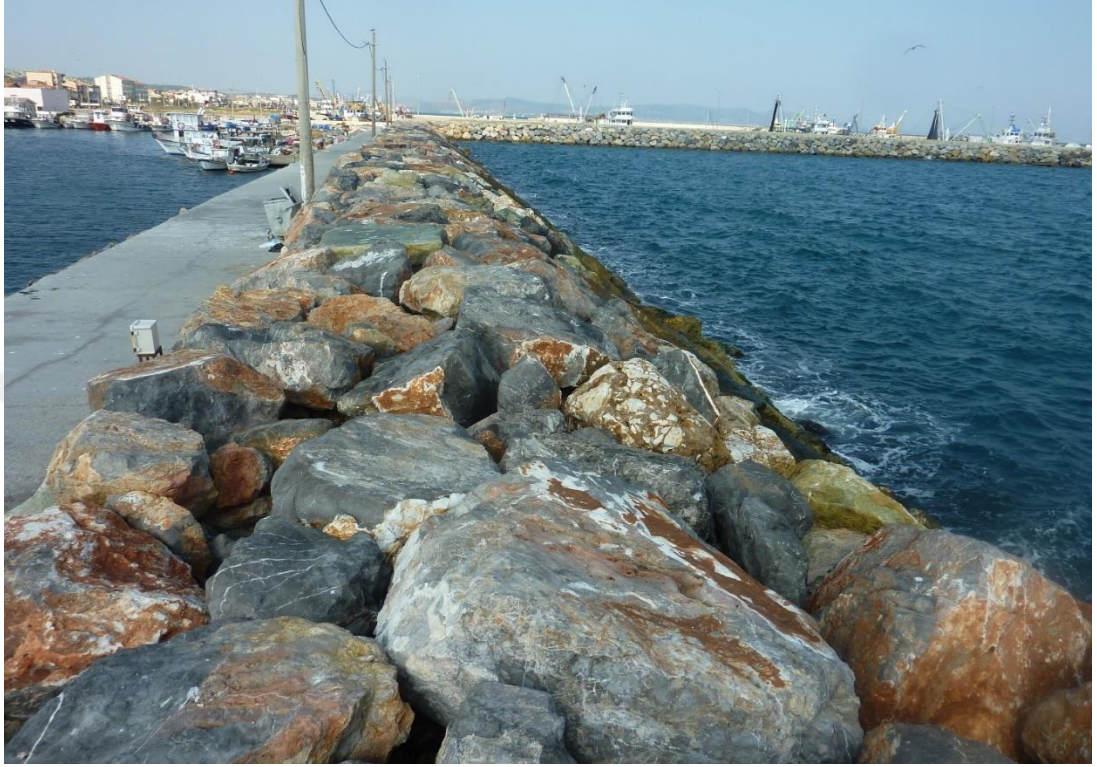
Şekil 1 Zırh taşlarının çalışma sahasında görünümü (Kişisel arşiv, 2016)
