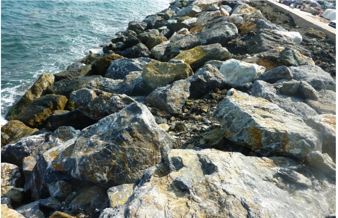
Şekil 6 Çalışma sahasında dalga kıranının şev kaymasının görünümü (Kişisel arşiv, 2016)
