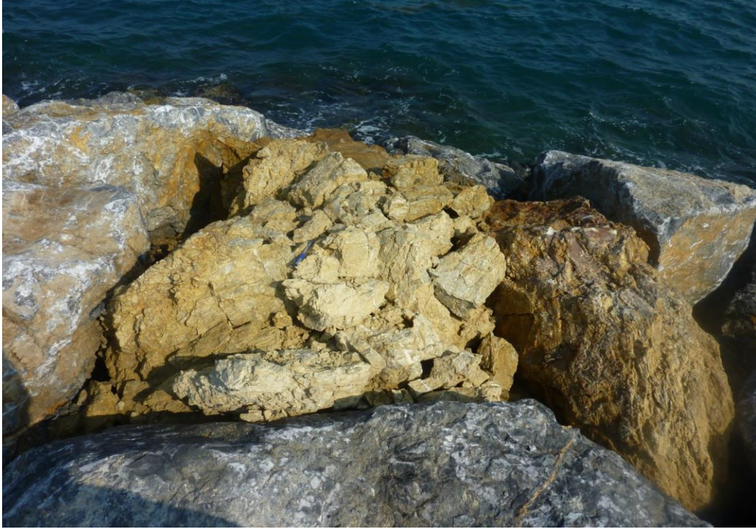
Şekil 4 Çalışma alanındaki zırh taşlarının tamamen parçalanmış görünümleri (Kişisel arşiv, 2016)
