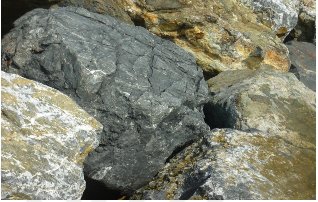
Şekil 5 Çalışma sahasında çok kırılmış zırh taşı blok görünümü (Kişisel arşiv, 2016)
