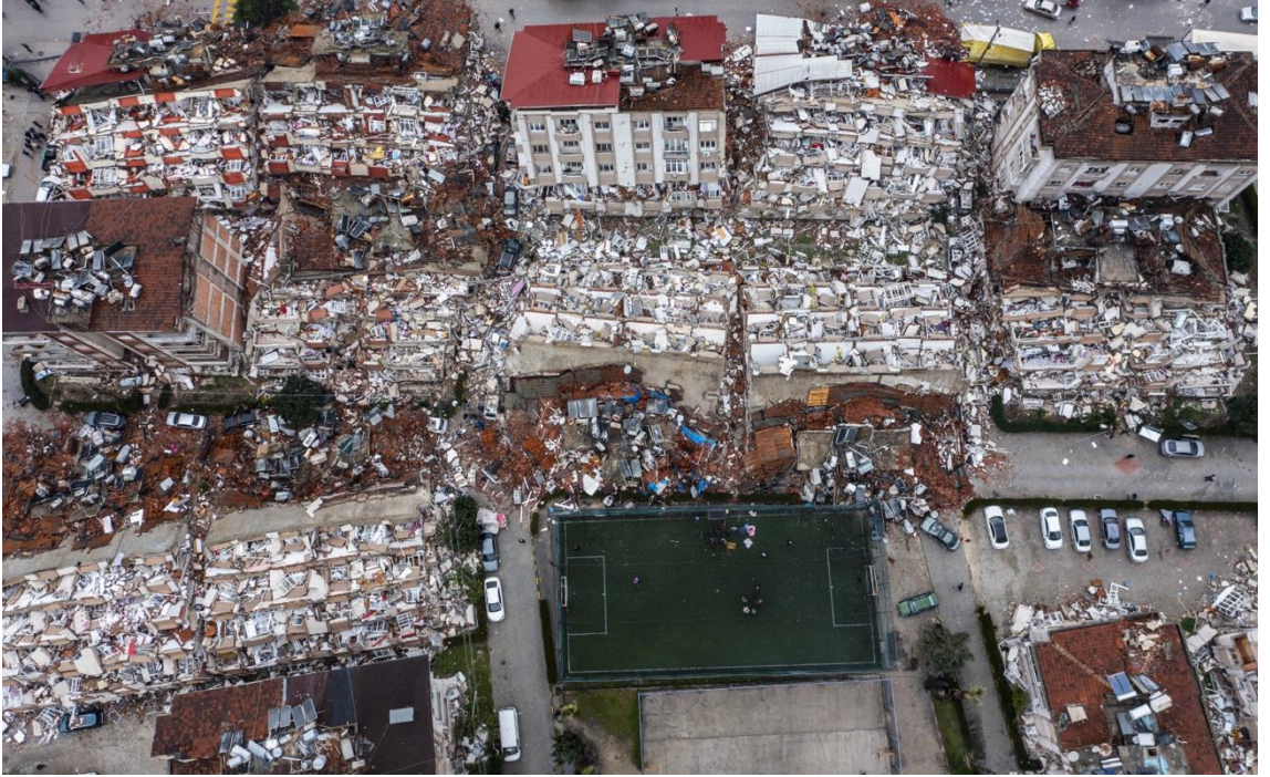
Şekil 4.6. Deprem Bölgesi Dron Görüntüsü (AA)
