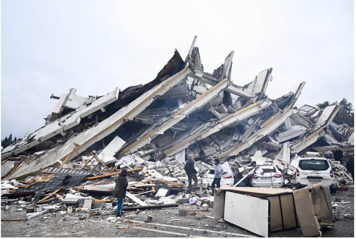
Şekil 4.7. Deprem Bölgesi Dron Görüntüsü (AA)
