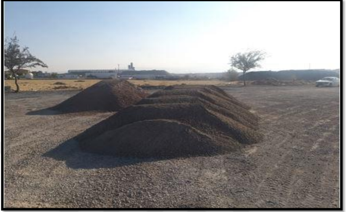
Şekil 5.38. Çalışma alanına taşınan malzeme.
