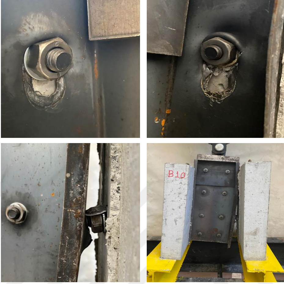
Şekil 52. PO-B-10 elemanında deney esnasında meydana gelen hasarlar
