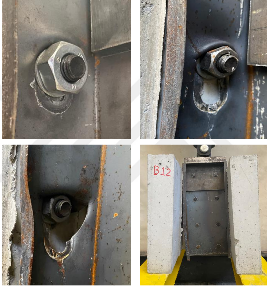
Şekil 54. PO-B-12 elemanında deney esnasında meydana gelen hasarlar
