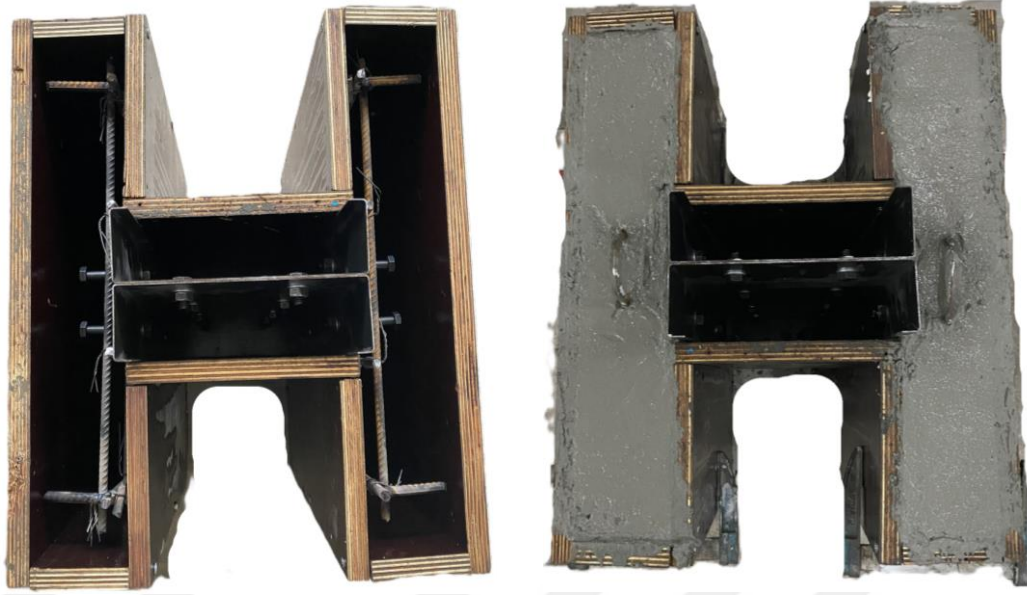
Şekil 35. Kalıbın hazırlanması ve beton dökümü
