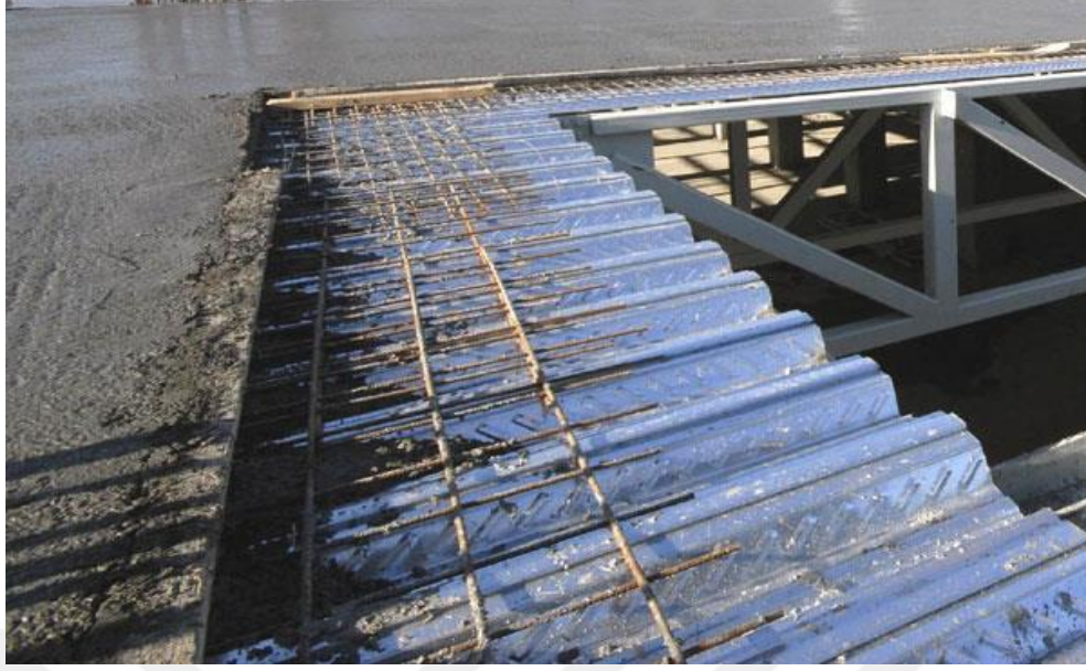
Şekil 2. Çelik beton kompozit döşeme uygulaması (URL-2)
