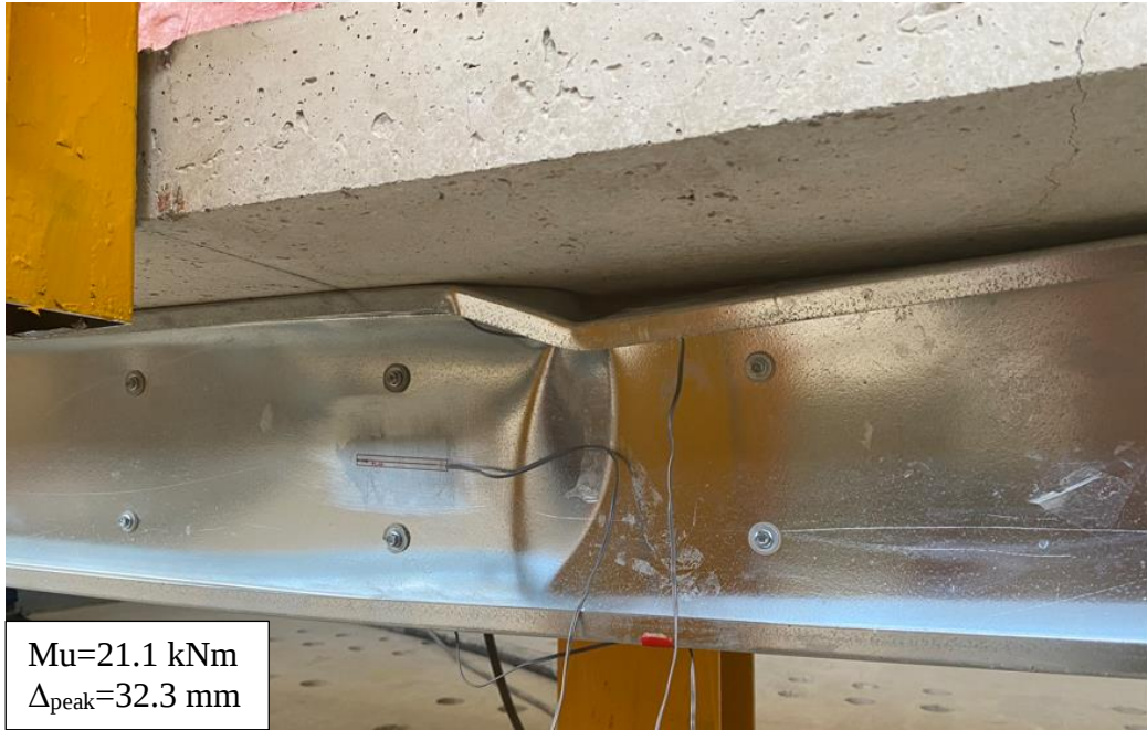
Şekil 61. BE-R numunesindeki hasarlar
