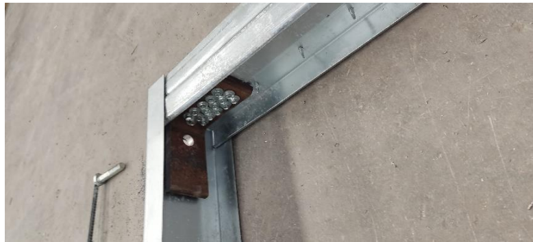
Şekil 5.20. Alt ve üst başlıklar ile kenar dikmelerin birleştirilmesi.
