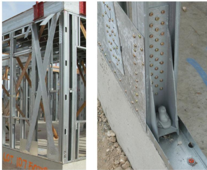
Şekil 2.8. Şerit çapraz bağlantı detayı
