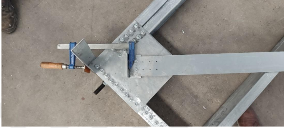
Şekil 5.26. Şerit çapraz elemanın mengene ile gerdirilmesi.
