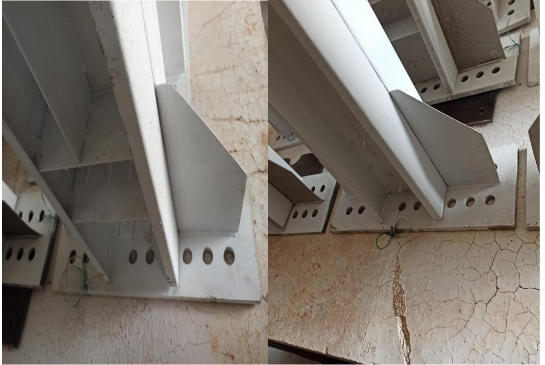
Şekil 4.1.Boyalı Kiriş-Alın Levhası-Guse Levha Birleşimi
