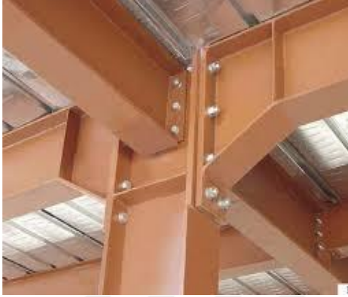
Şekil 2.14.Bulonlu birleşim
