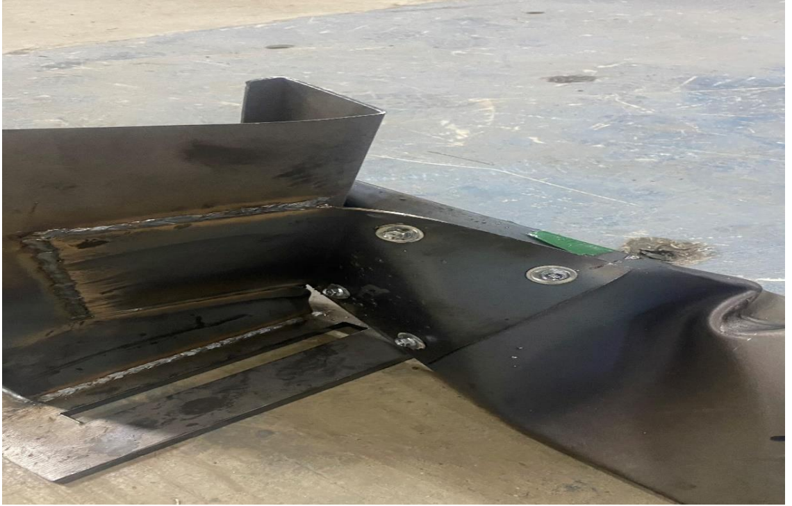
Şekil 4.77. 180 mm derinlikte kaynaklı birleşim kolon ve kiriş burkulması örneği (Yavuz 2023).
