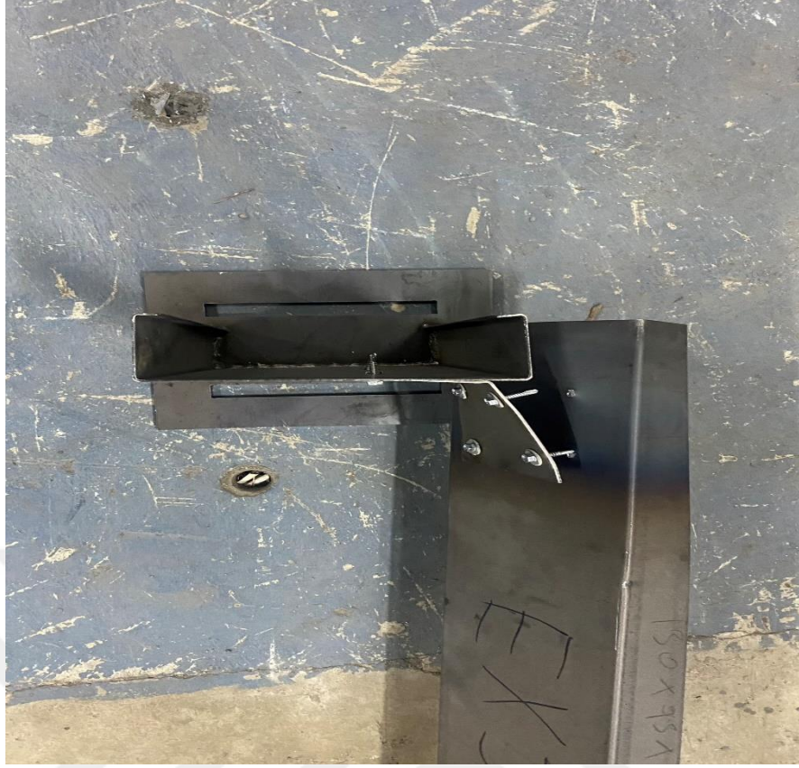
Şekil 4.68. Kolon burulmalı burkulması ve köşebent akıllı vida sıyrması örneği
