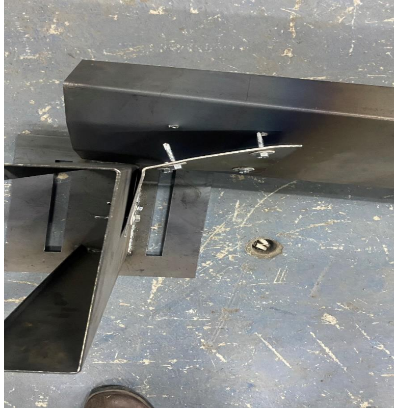
Şekil 4.69. Köşebent akıllı vida sıyrılma örneği
